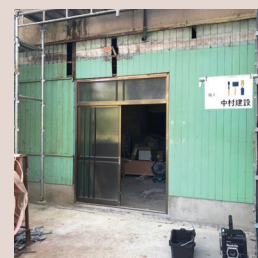
ガラス扉部分とハンガードアレベルになる上下を解体
