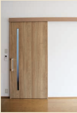
③ 扉設置、完成。
